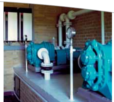
Compresores en modo de funcionamiento flexible, incluso por encima de la velocidad nominal y con máximo alto par durante el arranque, permite un mejor control y un mayor ahorro.
